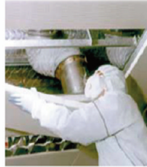
Tip 3 Sörvey Çalışması / Panellerin Sökülmesi
