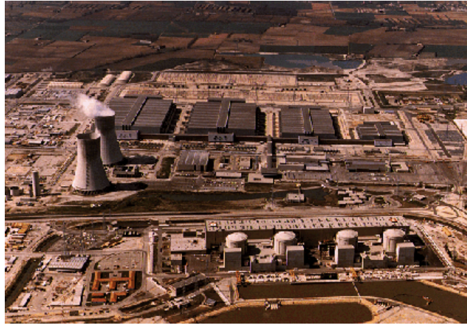
Fransa, Tricastin'deki, George Besse Uranyum Zenginleştirme Tesi-si. Solda görünen Soğutma Kuleleri'nin arkasındaki dört nükleer reaktör, 3000 MW elektrik gücünde çalışıyor olup, tesise gerekli enerjiyi sağlıyorlar.
