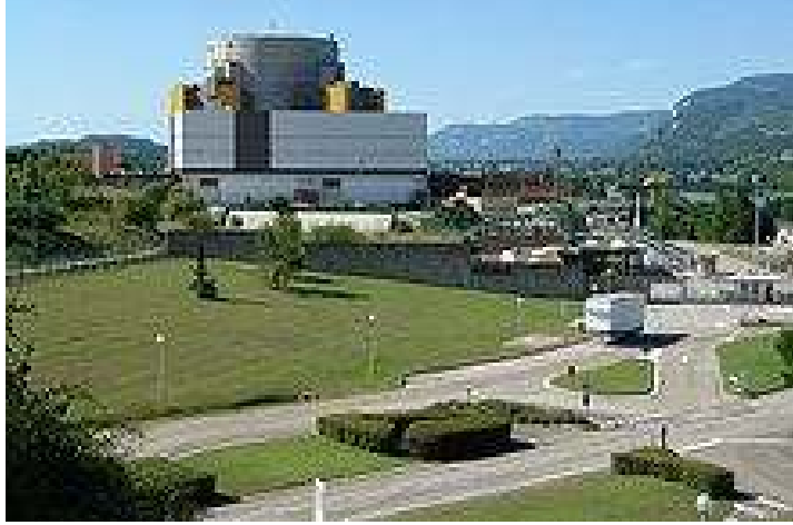
Rhone Nehri kıyısındaki, Fransız Superphenix Hızlı Üretken Reaktörü, türünün en büyük reaktörüdür. Elektrik Gücü 1200 MW'tır. Reaktör 1974 – 1981 arası inşa edilmiştir. 1985'te devreye alınmıştır. Ancak, ardarda yaşanan teknik sorunlar sebebiyle, bu atom mühendisliği harikası, 1998'de kapatılmıştır.
