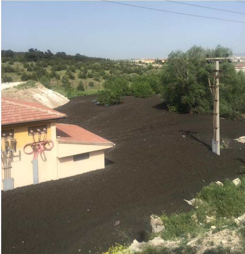
Resim 3: Kaza Yerine ait Görüntüler( OSB AAT Elektrik Trafosu)05.05.2018
