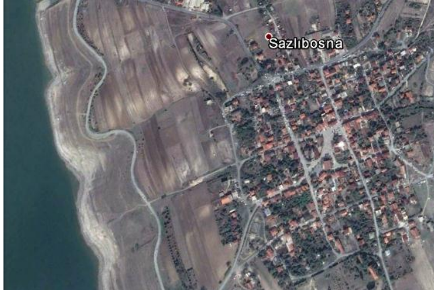
Şekil 7 Sazlıdere Barajı 2013 Yılı Görüntüsü
