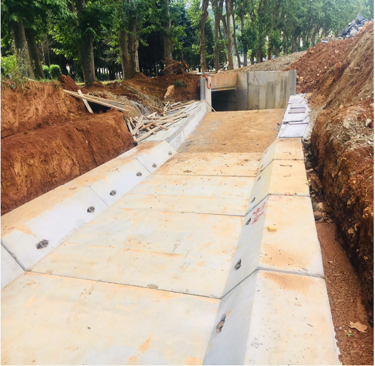
Resim Prefabrik dere temelleri
