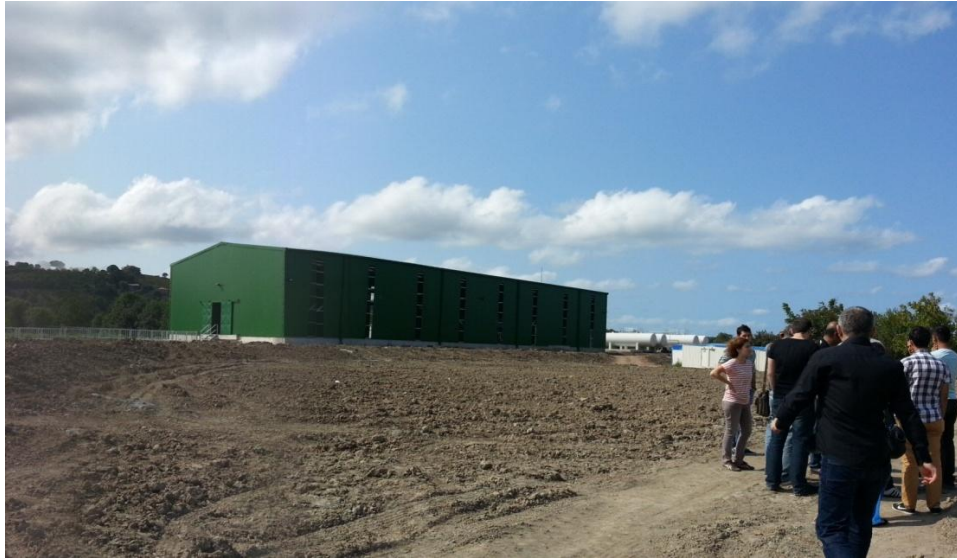
İSKİ Sakarya Terfi İstasyonu ve Su Alma Yapısı
