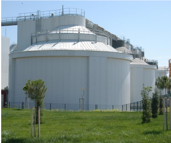
Anaerobik Çamur Çürütme
